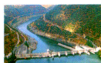
le barrage dam
